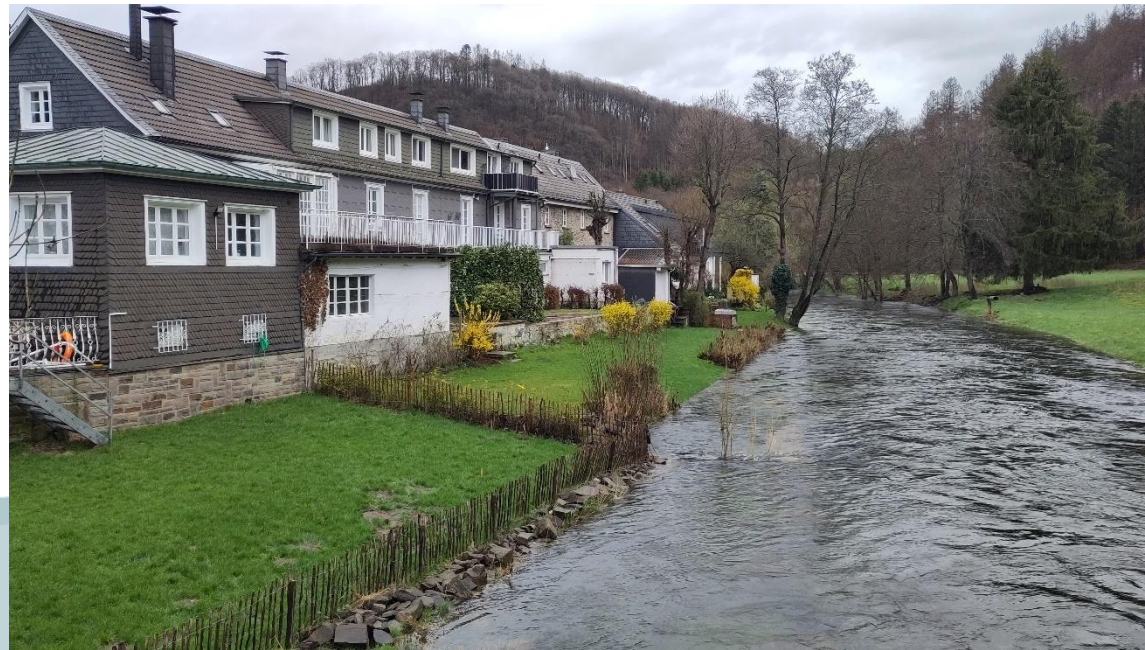
Sicht auf die Gebäude Beyenburger Furt 12-24 und die Wupper
